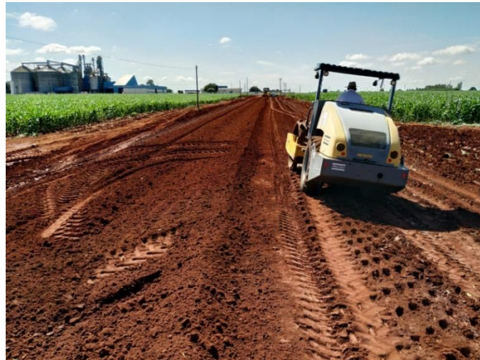
Figura 5: Compactação com rolo da estrada
