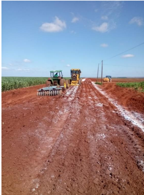
Figura 3: Incorporação do produto na camada de 20 cm
